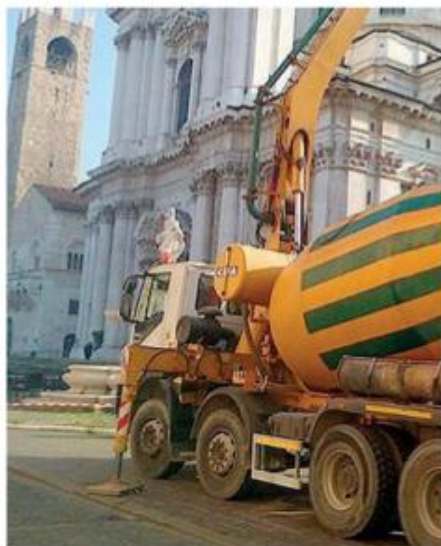
In piazza Duomo. Un'autobetoniera del gruppo Gatti all'opera
